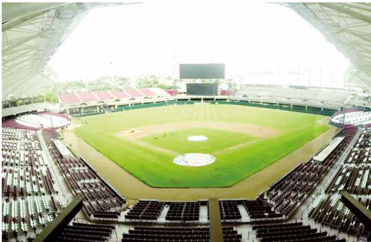
UN LEGADO DE JUAN MANUEL “EL CHINO” LEY al beisbol mexicano es la nueva casa de Tomateros, construida este año con el apoyo del gobernador de Sinaloa, Mario López Valdez (Malova). Un estadio muy bello, moderno y cómodo que tendrá capacidad para albergar a 16 mil aficionados.
