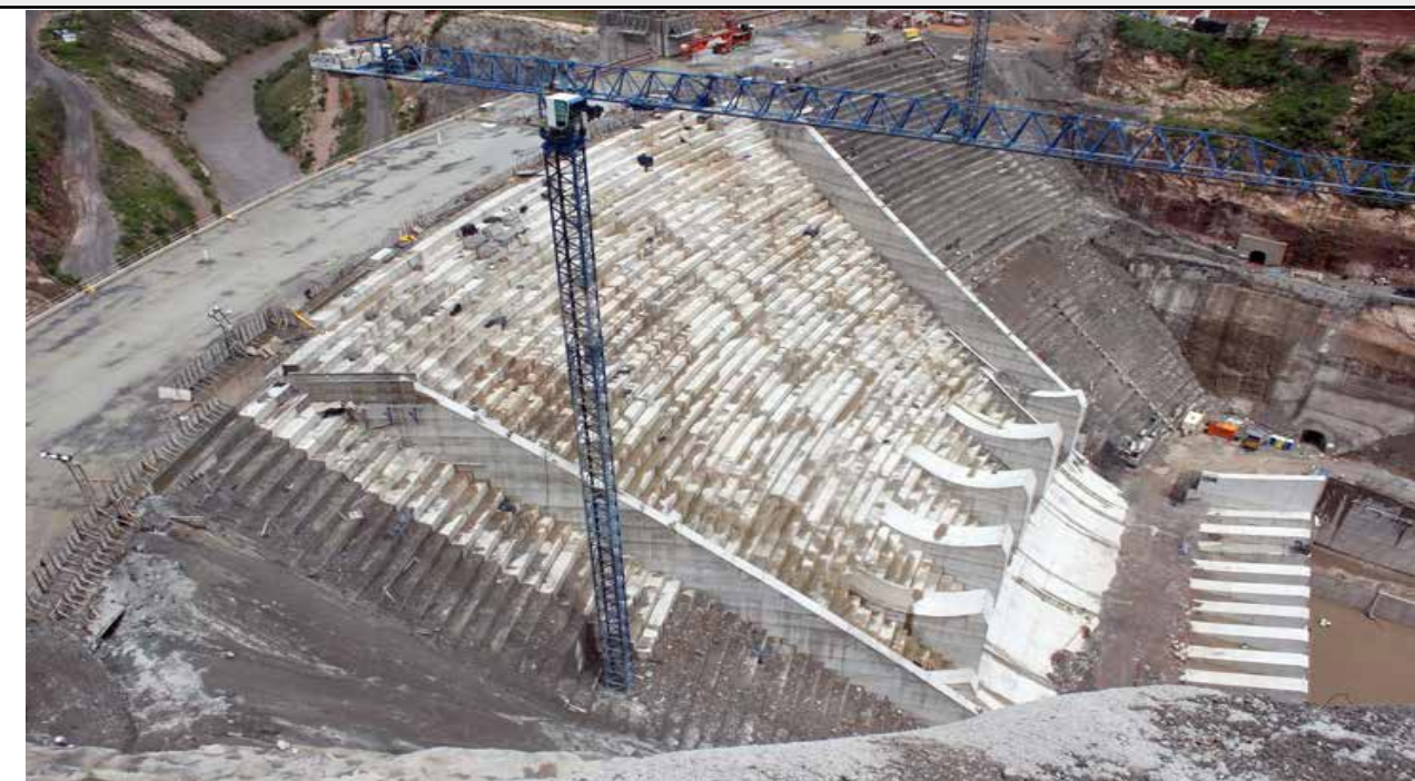
La presa de El Zapotillo, otro proyecto fallido del agua de Jalisco.
