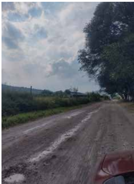
Imágenes de la brecha Calle Terranostra.
